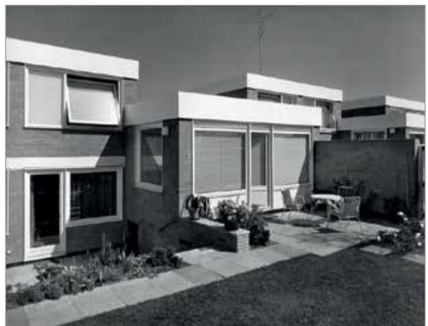
Durch ein geschicktes vertikales und horizontales Versetzen der Gebäudeteile entstanden geschützte Eingangs- und Terrassenbereiche. Foto: Heinrich Heidersberger, um 1965.
