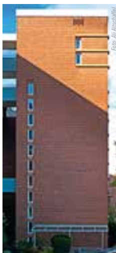
Auf der nördlichen Straßenseite führen in den Baukörper eingeschnittene Laubgänge zu den Wohnungen. Die Treppentürme sind frei davorgestellt.
