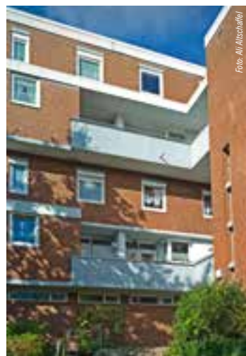
Auf der nördlichen Straßenseite führen in den Baukörper eingeschnittene Laubgänge zu den Wohnungen. Die Treppentürme sind frei davorgestellt.
