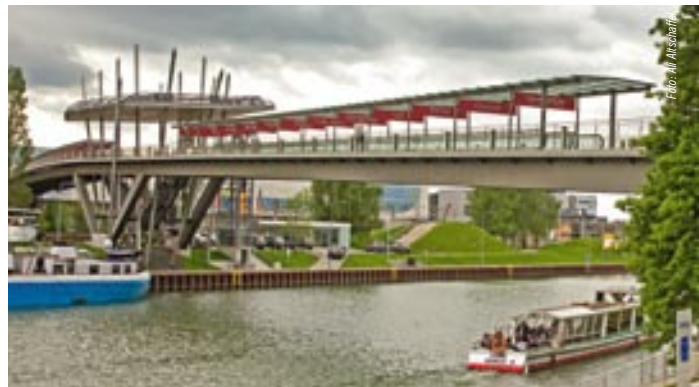
Stadtbrücke der Autostadt, 2000. Weithin sichtbares Zeichen ist das Dachelement in Brückenmitte, das von mikadoartigen Stützen gehalten wird.
