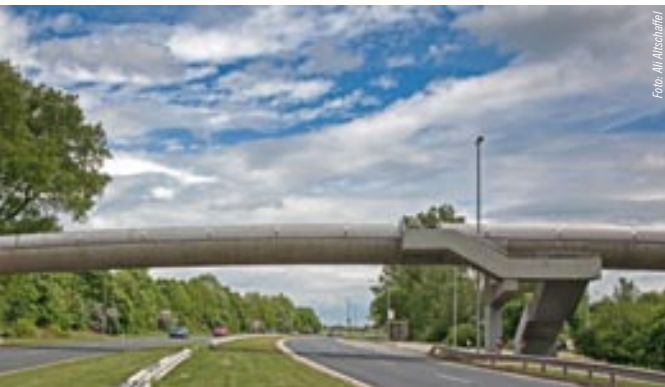
Die „Designerbrücke“ an der B 188, 1976. Elegant überbrückt die Konstruktion aus Spannbeton die viel befahrene Straße zwischen Allerpark und Teichbreite.
