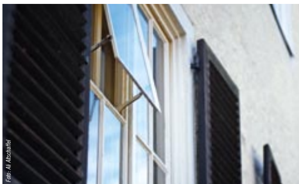
Hölzerne Doppelkastenfenster sorgen für eine gute Wärmeisolierung. In den Küchen und Bädern sind sie mit Lüftungsfüglern ausgeführt.
