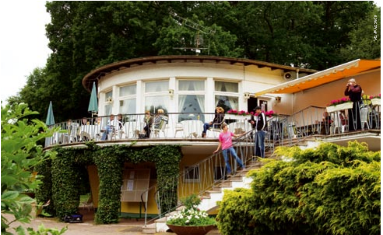
Vom außen liegenden Ringbalkon schweift der Blick über die Tennisplätze, deren terrassierte Anlage zu den landschaftsplanerischen Besonderheiten Wolfsburgs zählt. Die ursprünglich freitragende Galerie mit filigranen Geländern wurde nachträglich mit Stützen versehen. Sie sind heute stark berankt und nehmen dem Bauteil viel von seiner Leichtigkeit.
