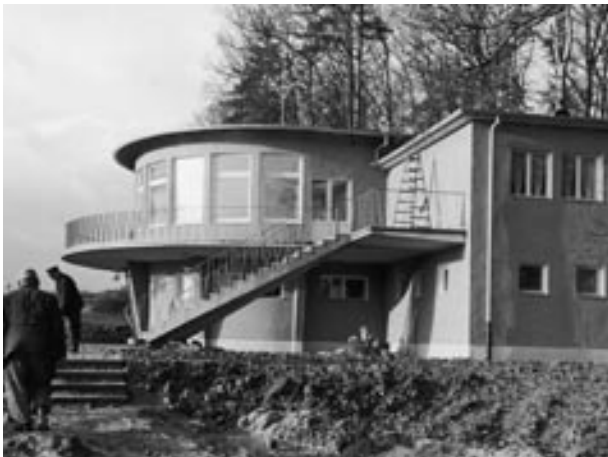
Vom außen liegenden Ringbalkon schweift der Blick über die Tennisplätze, deren terrassierte Anlage zu den landschaftsplanerischen Besonderheiten Wolfsburgs zählt. Die ursprünglich freitragende Galerie mit filigranen Geländern wurde nachträglich mit Stützen versehen. Sie sind heute stark berankt und nehmen dem Bauteil viel von seiner Leichtigkeit.
